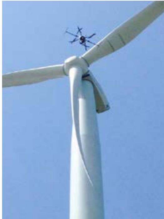
WIND TURBINE INSPECTION USING DRONE
